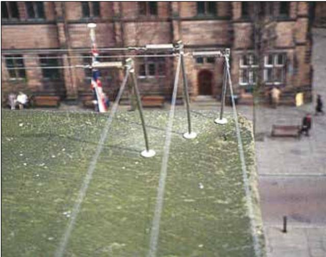
Este sistema es de los más usados para prevenir el posamiento de las palomas en las cornisas de los edificios en situaciones de presión baja. El sistema consiste de un alambre de acero inoxidable tensado mediante micro-resortes y con soportes de postes de acero inoxidable. Los postes vienen en distintos tamaños y el sistema es muy versátil, así se puede colocar sobre casi cualquier superficie.
